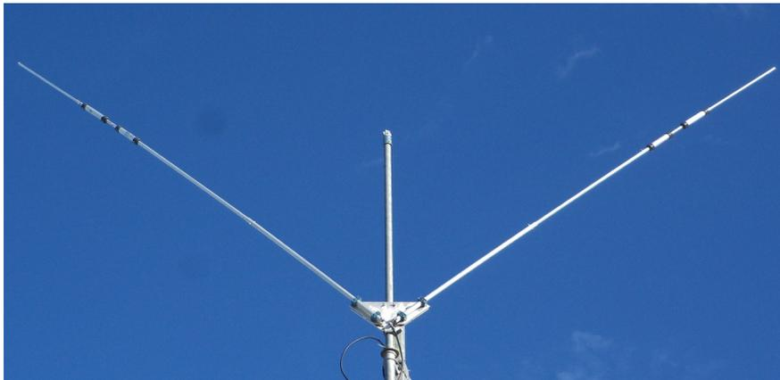
Dopo aver completato le operazioni di messa a punto, controllare il serraggio di tutti i dadi. Qualora il dipolo a V venisse montato al disopra di una yagi HF, è preferibile che esso sia installato parallelo al boom della yagi e ad una distanza verticale di almeno 1,5-2m. Se installato da solo è preferibile che sia ad almeno 5m dal solaio/tetto/suolo.
